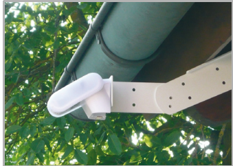
Abb. 8 Beispiel für den Einsatz eines Auslegers: Durch den Gelenk-Ausleger ragt der Sen-sor unter dem Dachvorsprung hervor.
