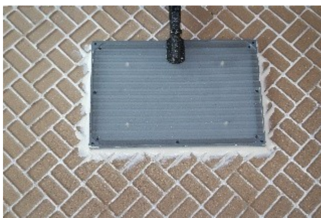
Abbildung 5: Verstreichen des Montageklebers
