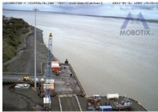
Ciudad de Dillingham, Seguridad Vial 80 cámaras MOBOTIX (EE. UU.)
