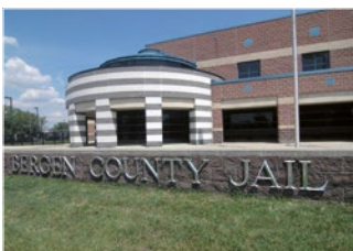
Cárcel del condado de Bergen 820 cámaras MOBOTIX (EE. UU.)
