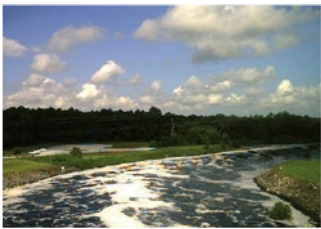
S. Florida Water Management District 147 cámaras MOBOTIX (EE. UU.)
