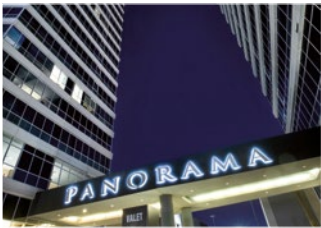
Panorama Towers 137 cámaras MOBOTIX (EE. UU.)
