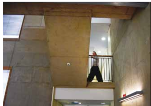
Figura 3. Eficiencia energética 2: abundancia de luz diurna y sensores de presencia controlando la iluminación. Fuente: Andromeda
