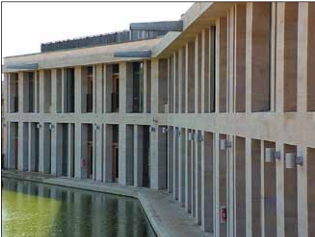
Figura 1. Centro SciTec de Oundle School, el cual reúne ciencia, arte y tecnología, y ha sido construido con la ayuda de tecnologías sostenibles orientadas al futuro tales como KNX. Fuente: Andromeda
